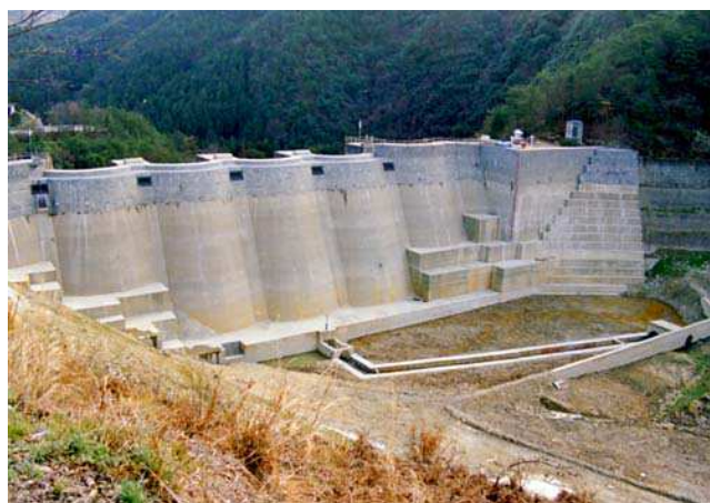
上流から見た湛水前の全景・5連のアーチがよくわかる
