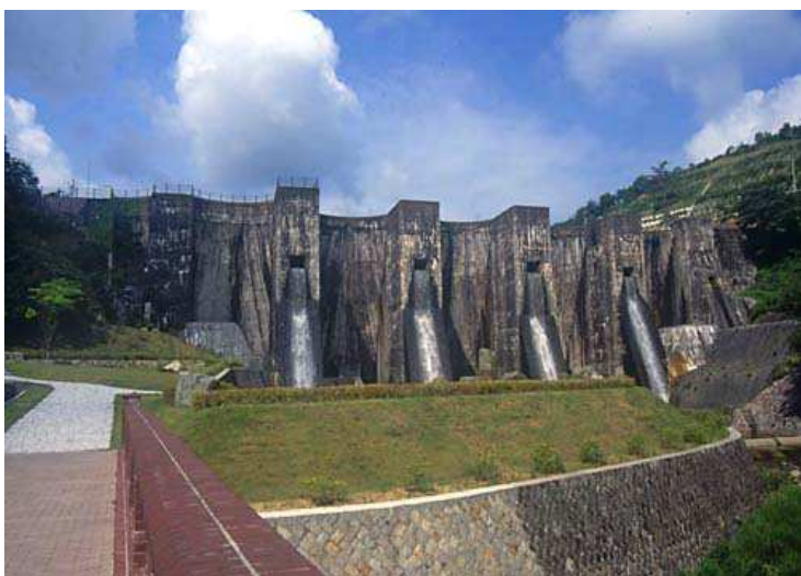
下流からのダム全景
