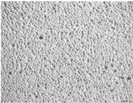
気泡コンクリートの表面
