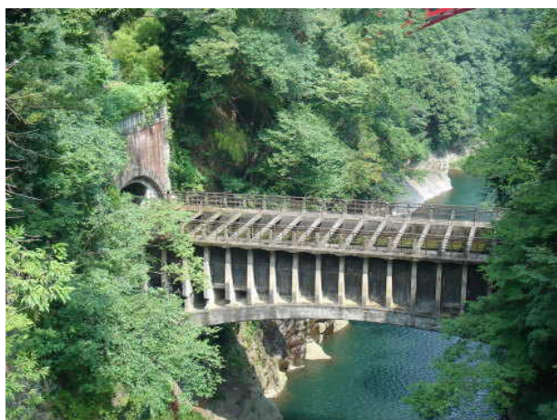
猿橋水路橋（鉄筋コンクリート開腹アーチ）
