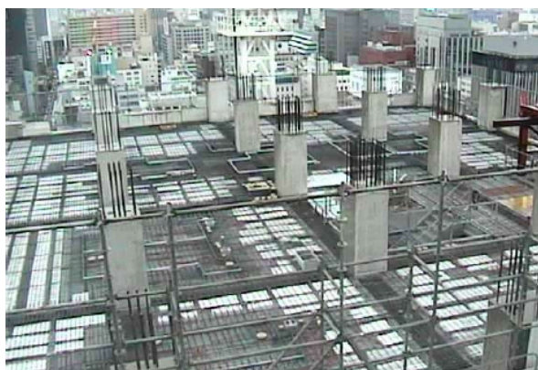
プレキャストコンクリート部材の建込
