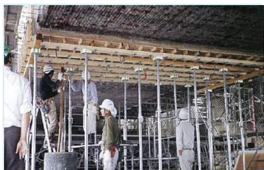
充填（注入）工法
