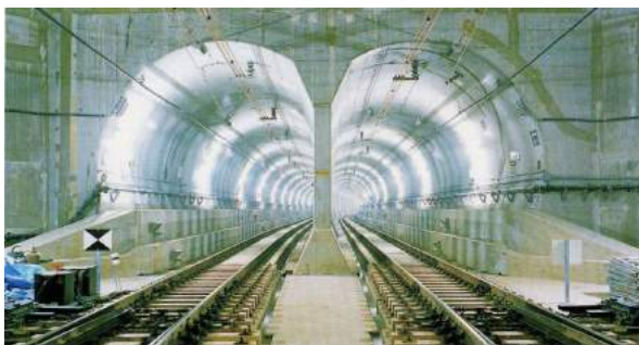
京葉線京橋トンネルの坑口
