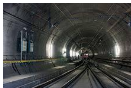
トンネル内部
