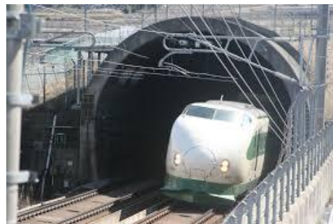
中山トンネル
