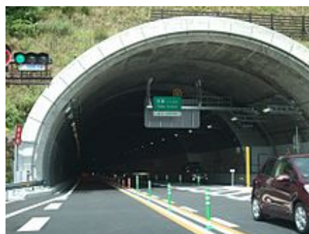
飛騨トンネル河合坑口
