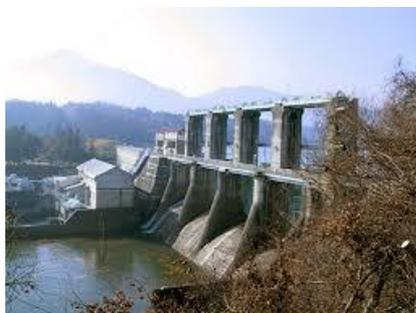
石羽根ダム（重力式コンクリート・フィル複合ダム）
