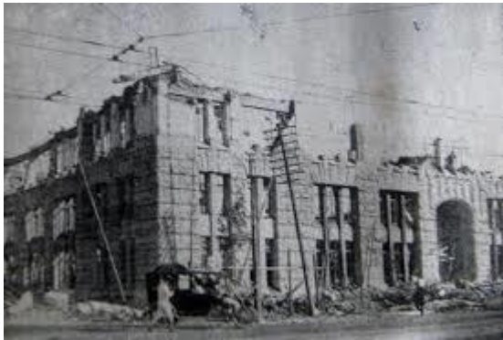
関東大震災で全壊した内外ビルディング
