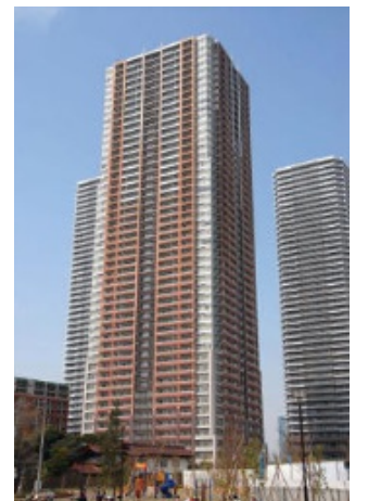
150N/mm 2 のコンクリートを用いたザ・コスギタワー B1,49F
