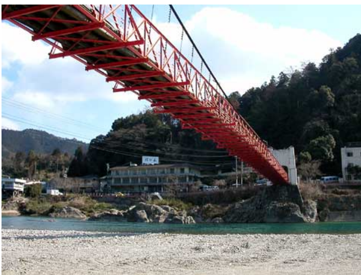
河原から見上げた美濃橋
