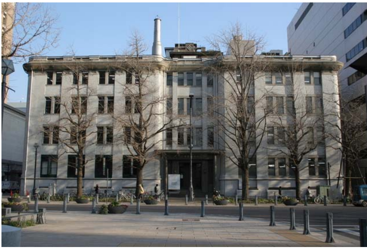
向かって左側が1号館、右側が2号館 鉄筋コンクリート造4階建て、地下1階
