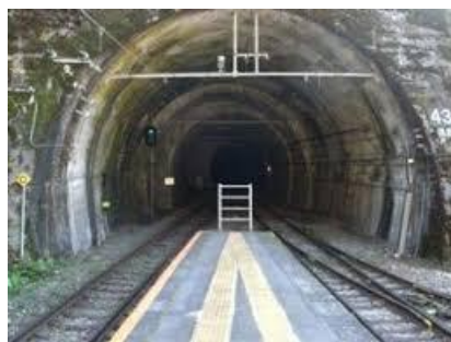
飯田線大原トンネル
