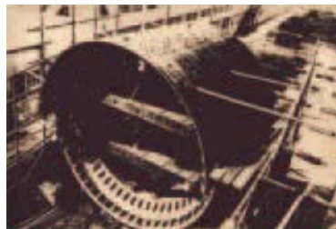
関門鉄道トンネルで使用されたシールドマシン
