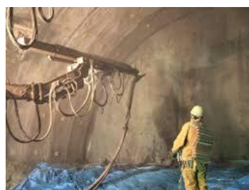
吹付けコンクリート
