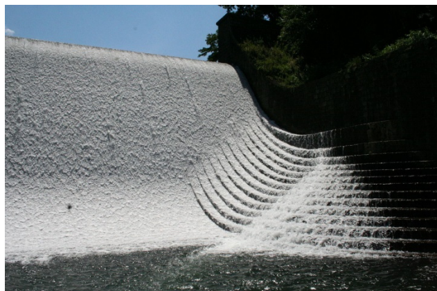
左岸端部 階段状流路
