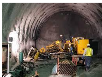
先進ボーリング
