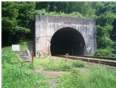
北陸トンネル
