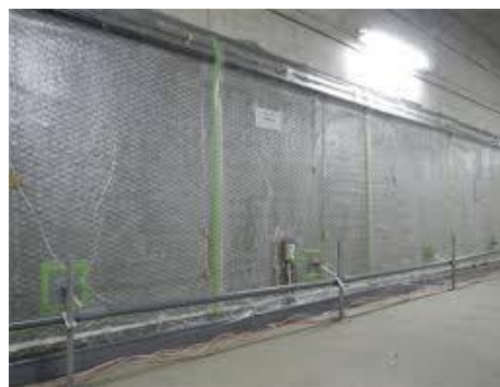
再アルカリ化工法の実施状況
