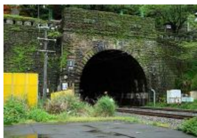
丹那トンネル
