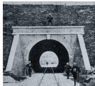
石屋川トンネル
