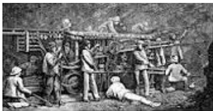
削岩機による工事
