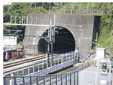
新丹那トンネル
