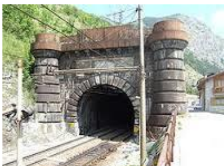
フレジュス鉄道トンネルのイタリア側坑口
