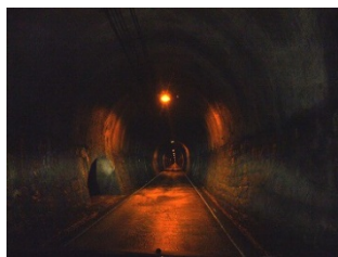
トンネル内部
