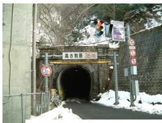
柳ヶ瀬トンネル
