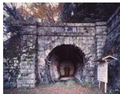
逢坂山トンネル（旧逢坂山隧道）東口
