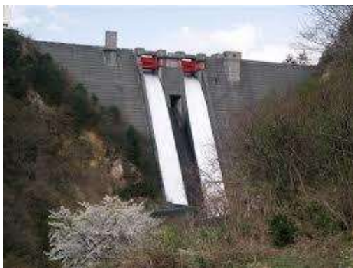
内の倉ダム（中空重力式コンクリートダム）
