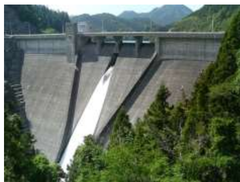
島地川ダム（世界で初めてRCD工法を採用）
