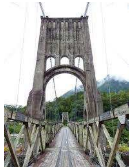
鉄筋コンクリート製の主塔 橋の中央にトロッコのレールを模した板が敷かれている
