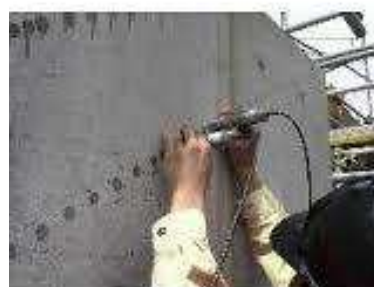
超音波試験状況
