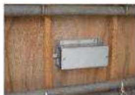
ボス型枠の取り付け
