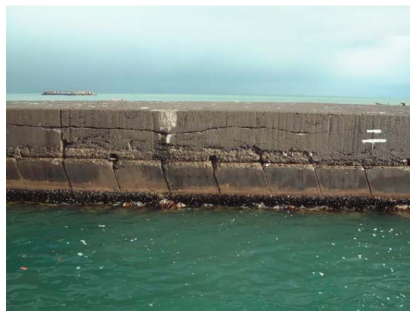
防波堤本体の傾斜ブロック (下部の斜めに積まれたブロック)
